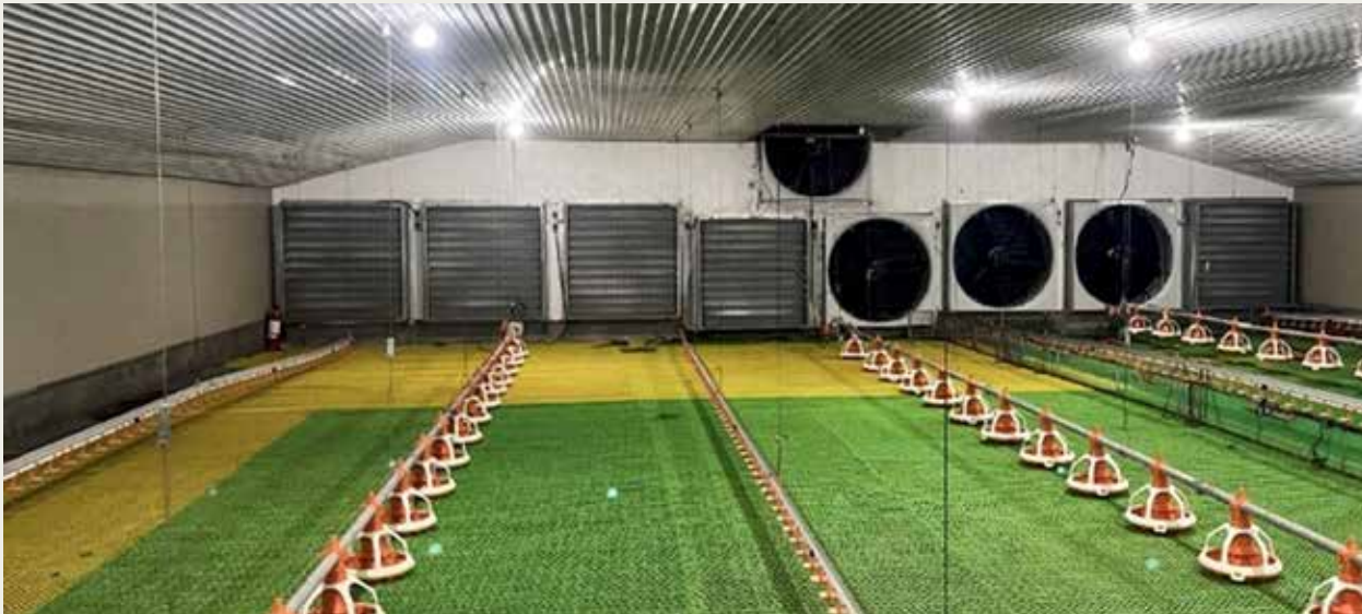
Udskiftning af gamle galvaniserede kasseventilatorer med nye BF 50 BlueFans
