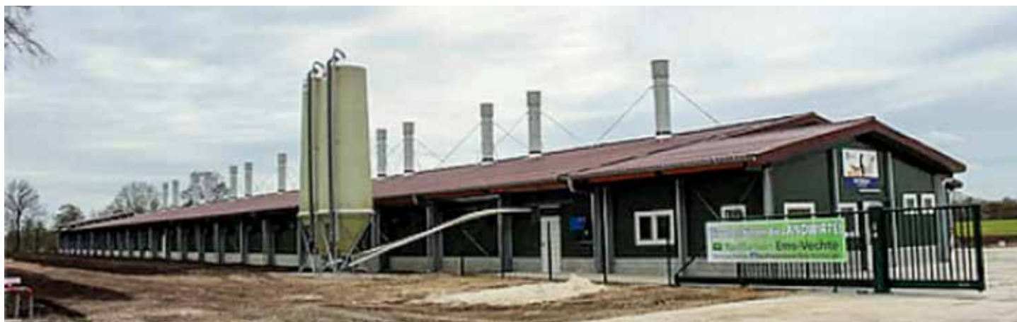
Slagtekyllingehuset, der blev en imponerende opdrætsstald
