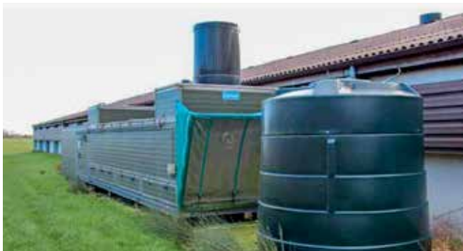
En ny Agro Supply varmeveksler blev installeret ved siden af det nyeste fjerkræhus.
