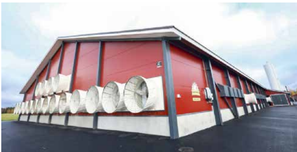
Fjerkræstalden er udstyret med tunnelventilation. Fordi det er efterår og allerede køligt, forbliver luftindtaget for det meste lukket. Foto: Henk Riswick
