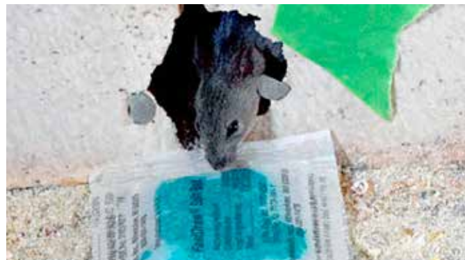
Huller i fjerkræstalde bør lappes for at forhindre gnavere i at få adgang til bygningen. Foto: Liphatec
